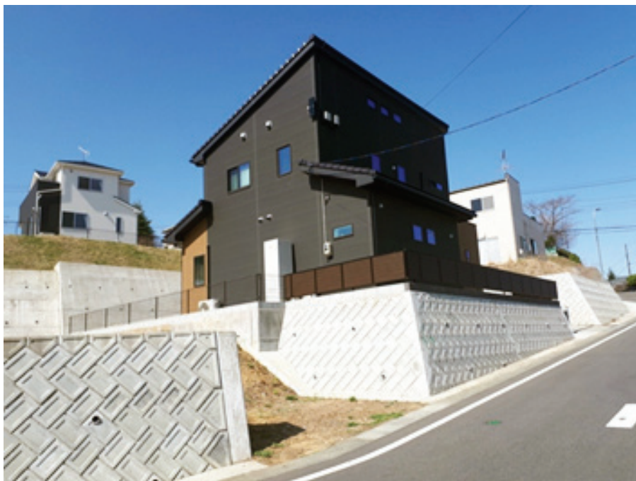
Foto 7 Residências alteadas devido à movimentação do terreno durante o tsunami.
