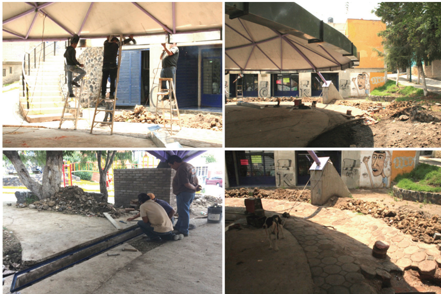
Figura 5 Fotografias da construção do domo captador de água. Fonte: Rozana Montiel. 7
