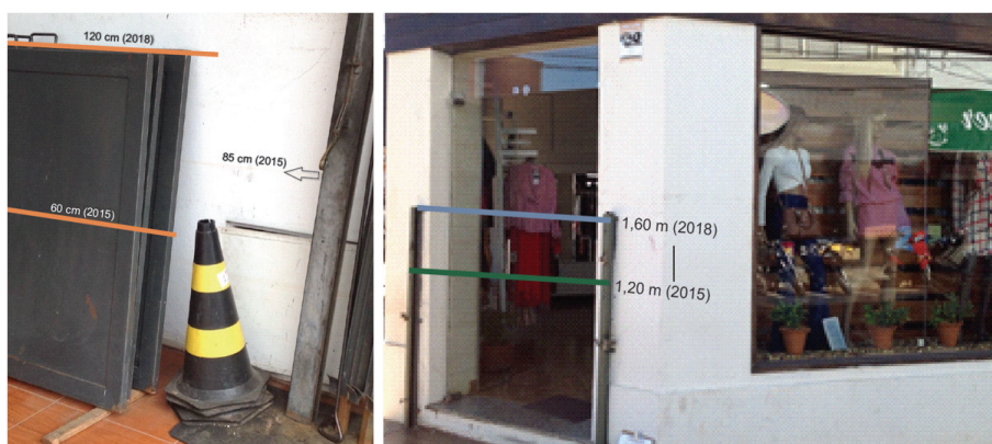
Figura 4 Exemplos de comportas instaladas nos imóveis afetados pelas inundações.
