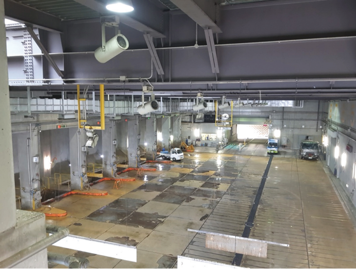
Foto 4 Pátio de descarga do incinerador – Tohokubo Clean Center.
