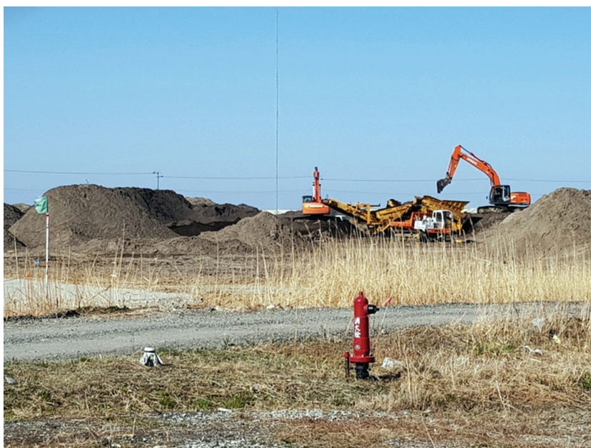
Foto 12 Locais de armazenamento temporário de RD e obras em andamento.
