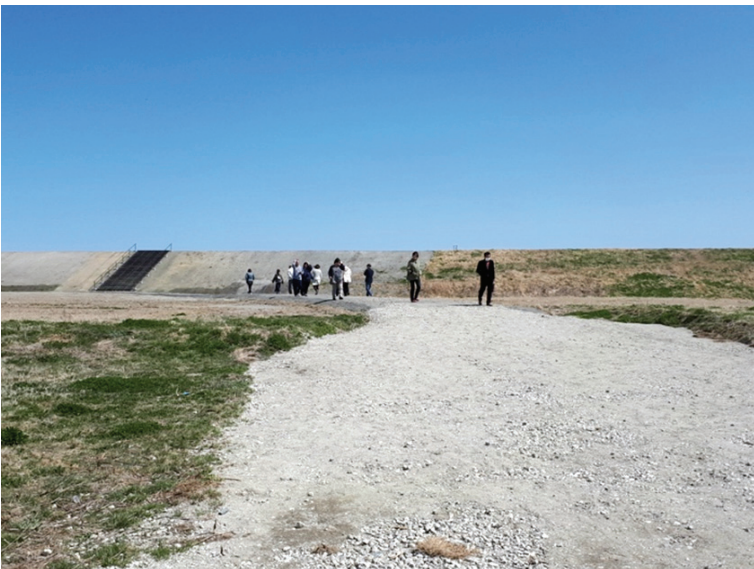
Foto 14 Diques de contenção.
