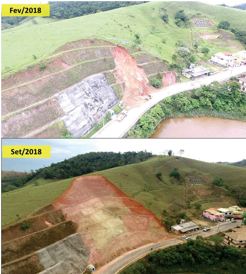
Figura 10 Ortofotos obtidas pelo drone no monitoramento do talude da Rodovia João Roman em São Luiz do Paraitinga (SP).
