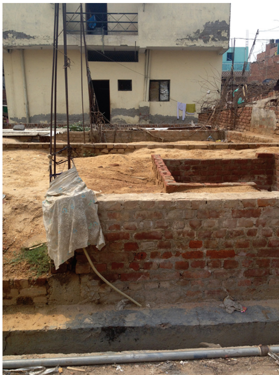
Figura 4 Casa no processo de elevar suas fundações acima dos níveis de água da inundação. Fonte: Cureindia. Centro de Excelência Urbana e Regional 6 .
