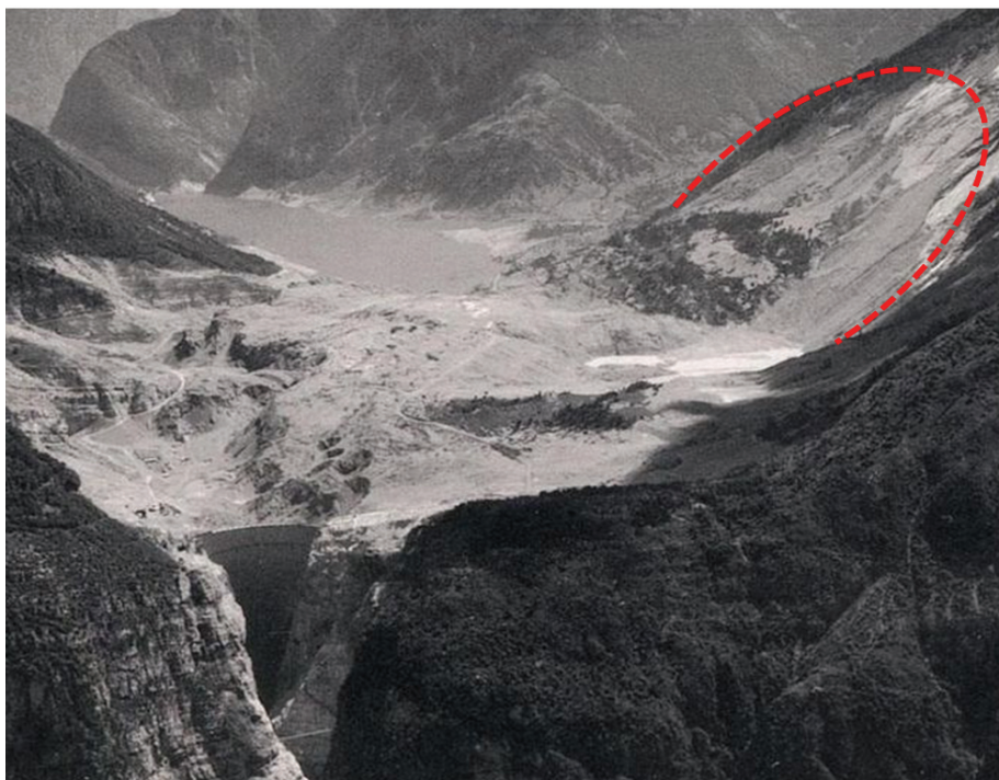
Figura 5 Barragem de Vajont após a ruptura. No canto superior direito da foto observa-se a cicatriz da área de ruptura. Percebe-se ainda que a estrutura de concreto da barragem ficou intacta. Fonte: Wikipedia.org.
