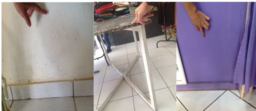
Figura 3 Marcas atingidas na inundação de 2018 de acordo com os afetados.
