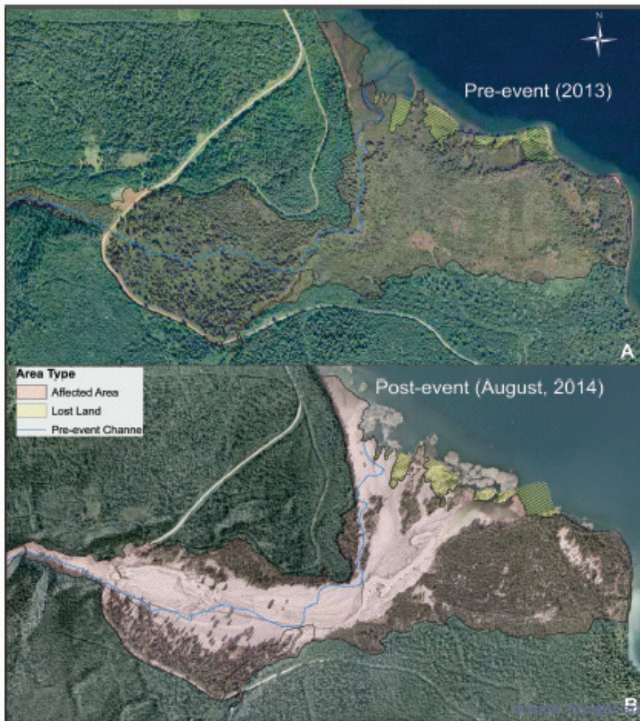
Figura 12 Barragem de Mount Pulley, antes (A) e após o seu rompimento (B). Fonte: Morgeinstern et al. (2015).
